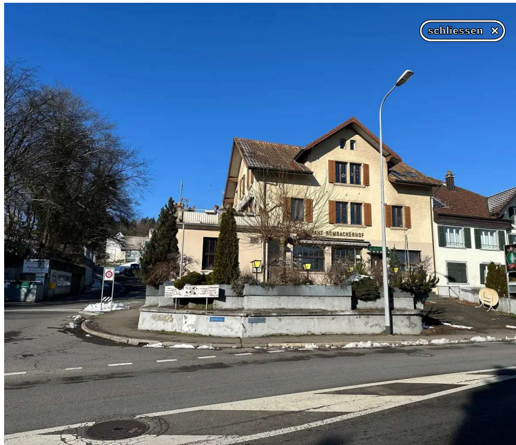
Der «Rombacherhof» liegt im Projektperimeter.
