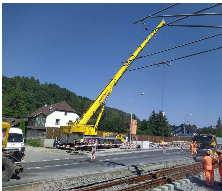
In Oberkulm wird der neue Deckbelag auf der Hauptstrasse eingebaut.
